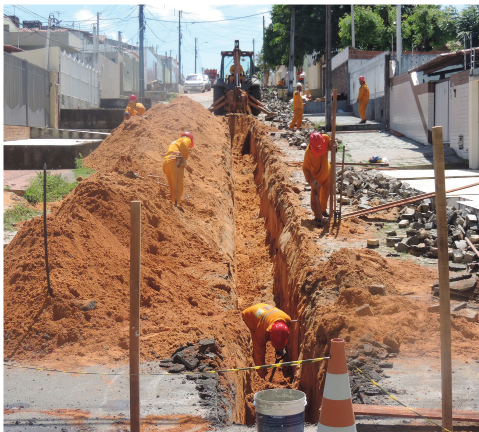
Os trabalhos devem prosseguir até o próximo ano quando será feita a instalação das 57 Estações Elevatórias
